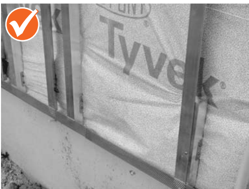
Pareizais L profila montāžas veids aiz vertikālās sadure šuves.
