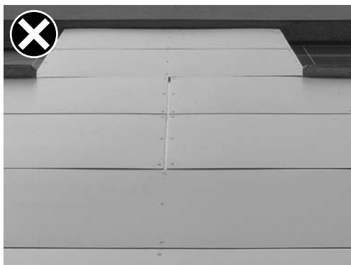
Pārsniegts balstu attālums
